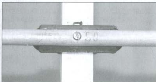
Figure 2: Mounting the elements with Polyamide brackets (only bottom parts) Bild 2: Befestigung der Elemente mit den Polyamid-Klammern (nur Unterteile)
